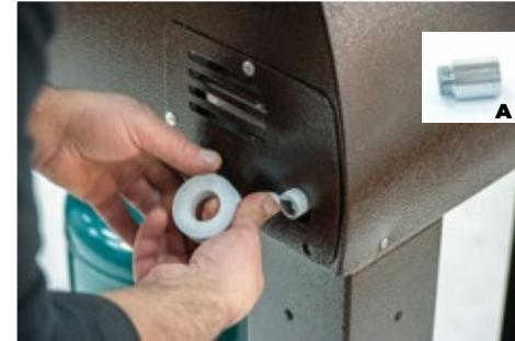
1. Isolare con teflon l'attacco gas forno e avvitare il connettore (A) di collegamento.
